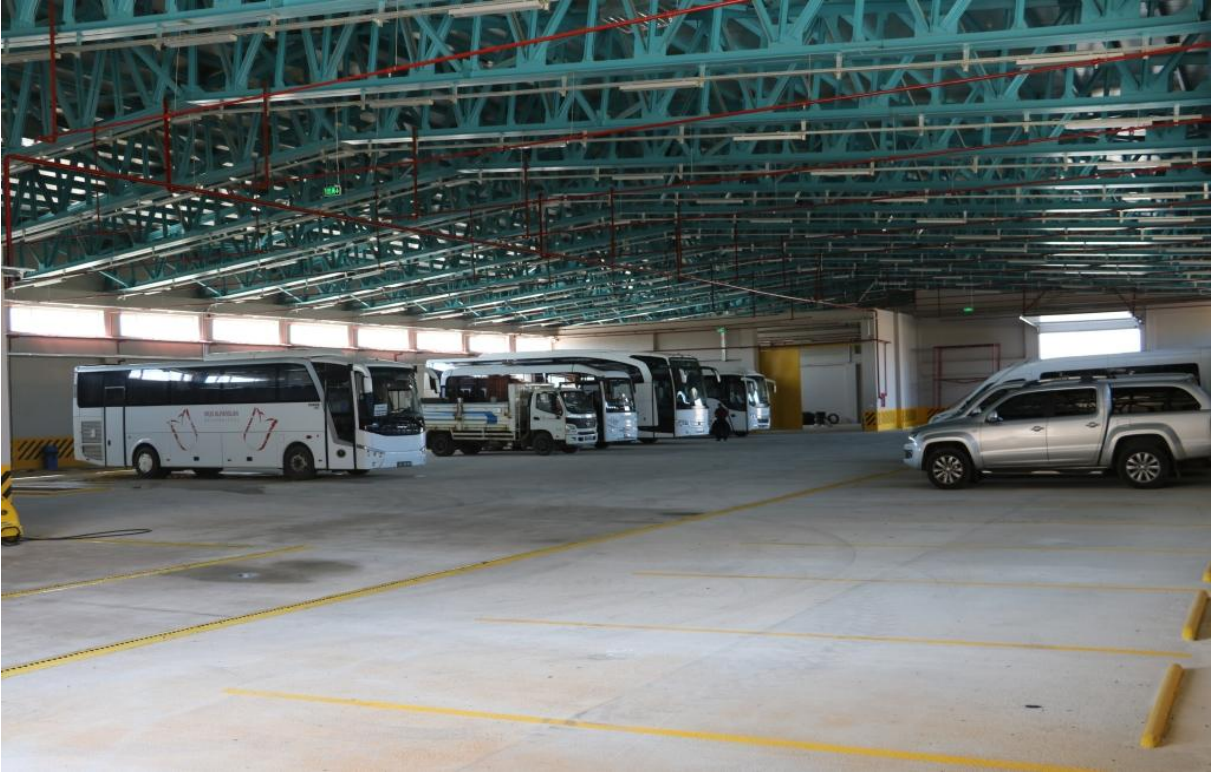
Resim 4. Hangar İç Görünüm
